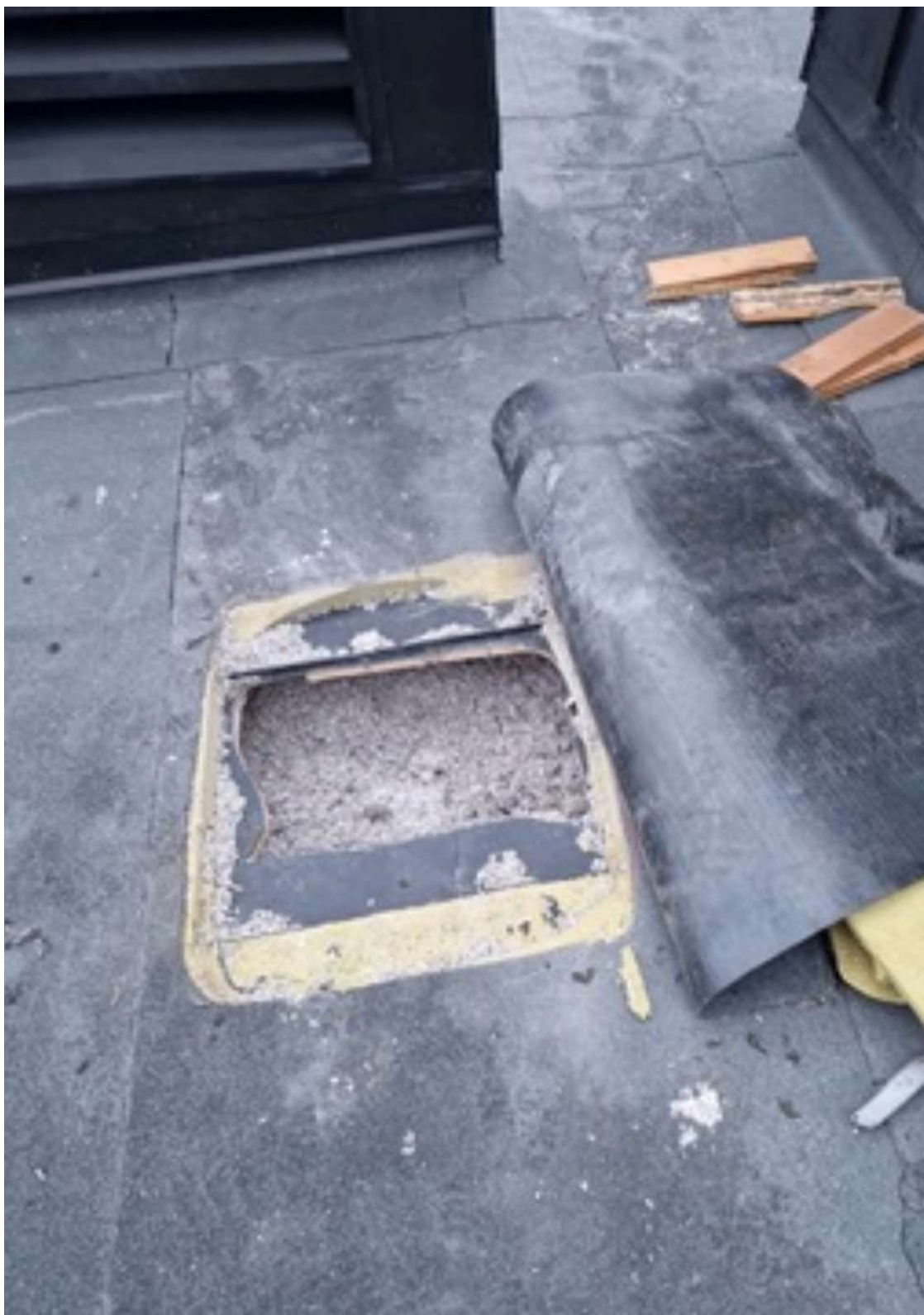
Bild på resultat av tilläggsisolering. Då hela utrymmet numera är fyllt med isolering är det svårt att dokumentera efterresultatet på ett mer tydligt sätt.
