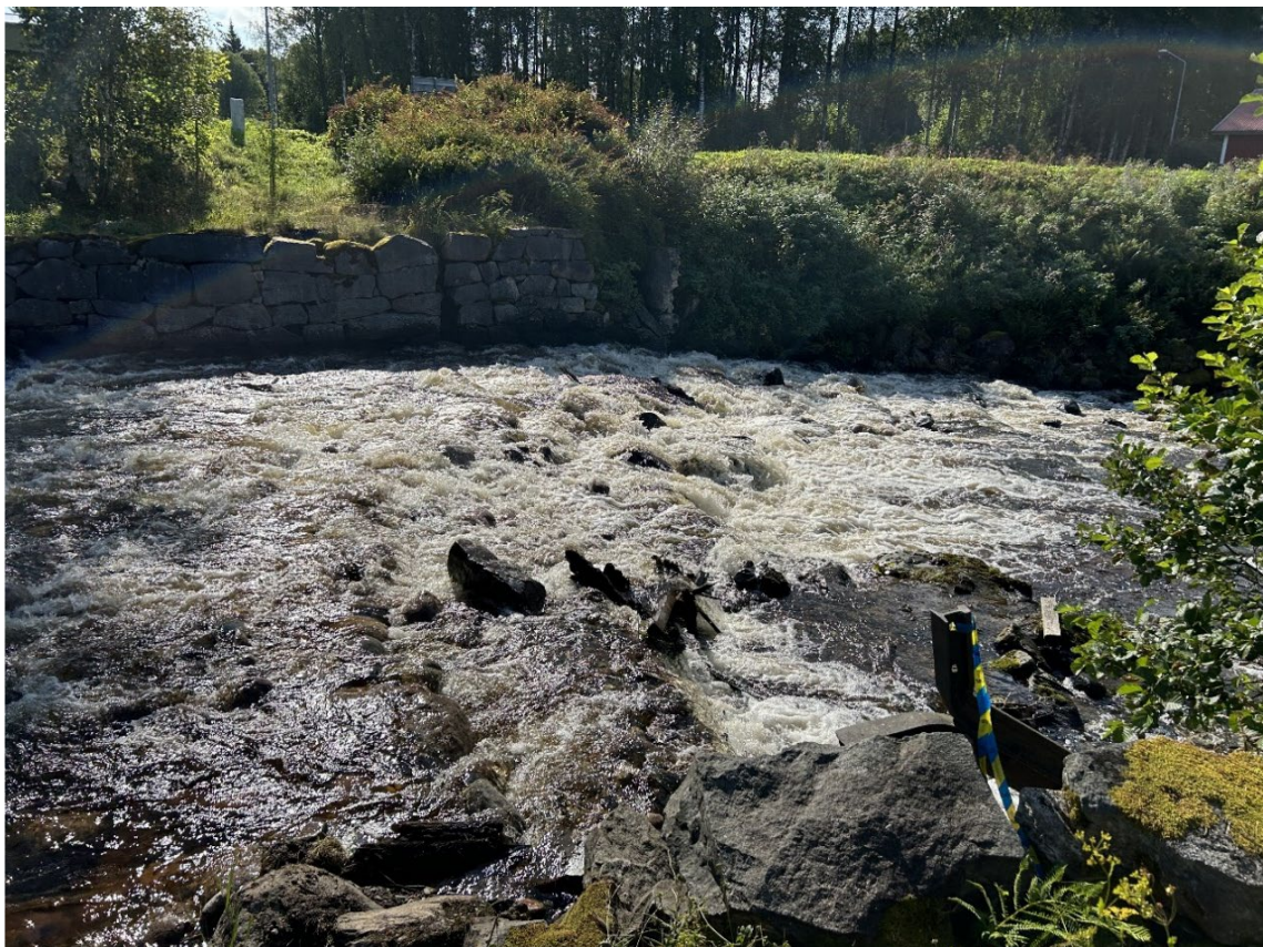
Figur 12. Tidigare dammläge efter att järnräler, tröskelstockar och stenfyllning avlägsnats (foto Norconsult). Närmst i bild, nere till höger syns järnrälen som sparats för att markera det tidigare dammläget (markerad med blå-gul snitsel)
