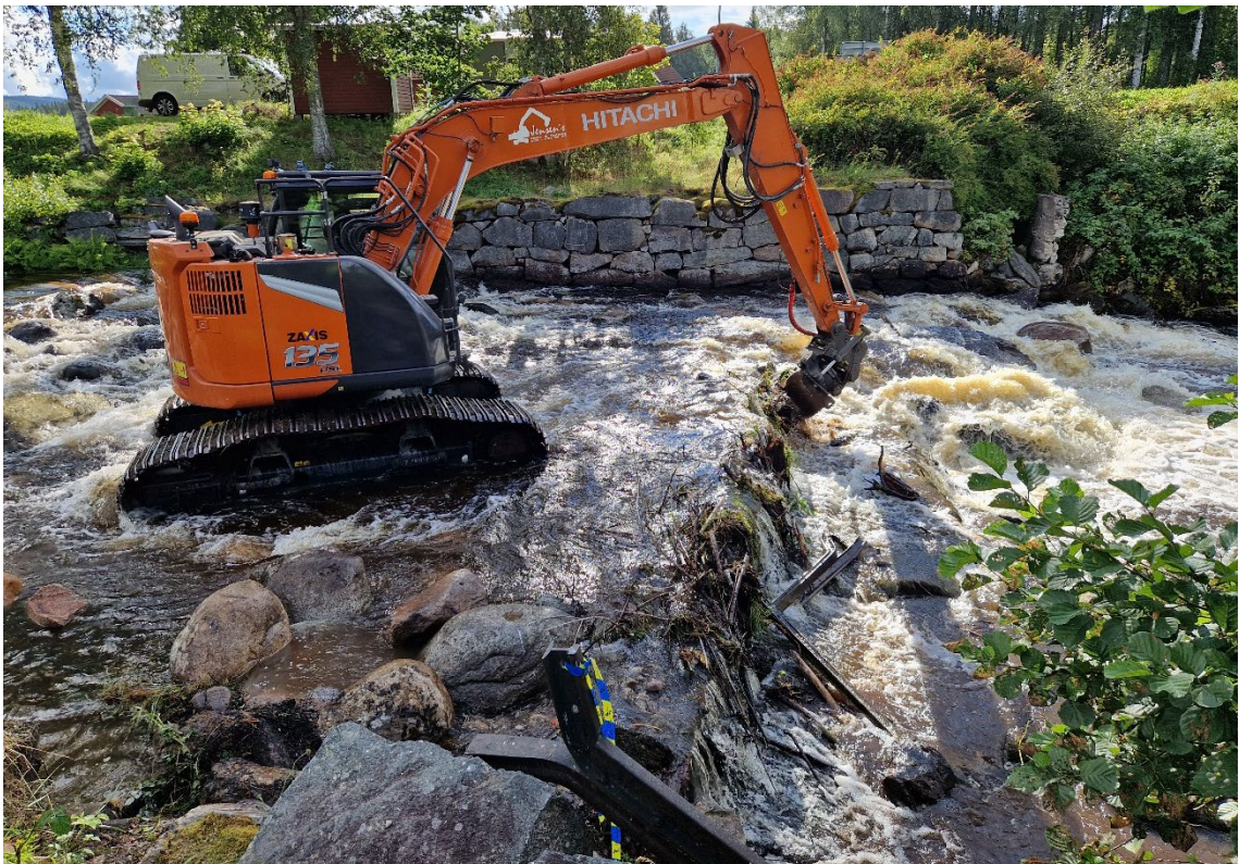
Figur 10. Rivningsarbeten av den tidigare dammanläggningen (foto Norconsult). Närmast i bild, syns järnrälen som sparats för att markera det tidigare dammläget (markerad med blå-gul snitsel).
