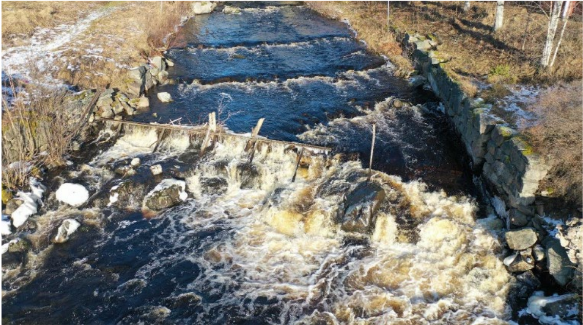
Figur 2. Aktuell vattenanläggning som raserats och strömsträcka som biotopvårdats (foto Norconsult).
