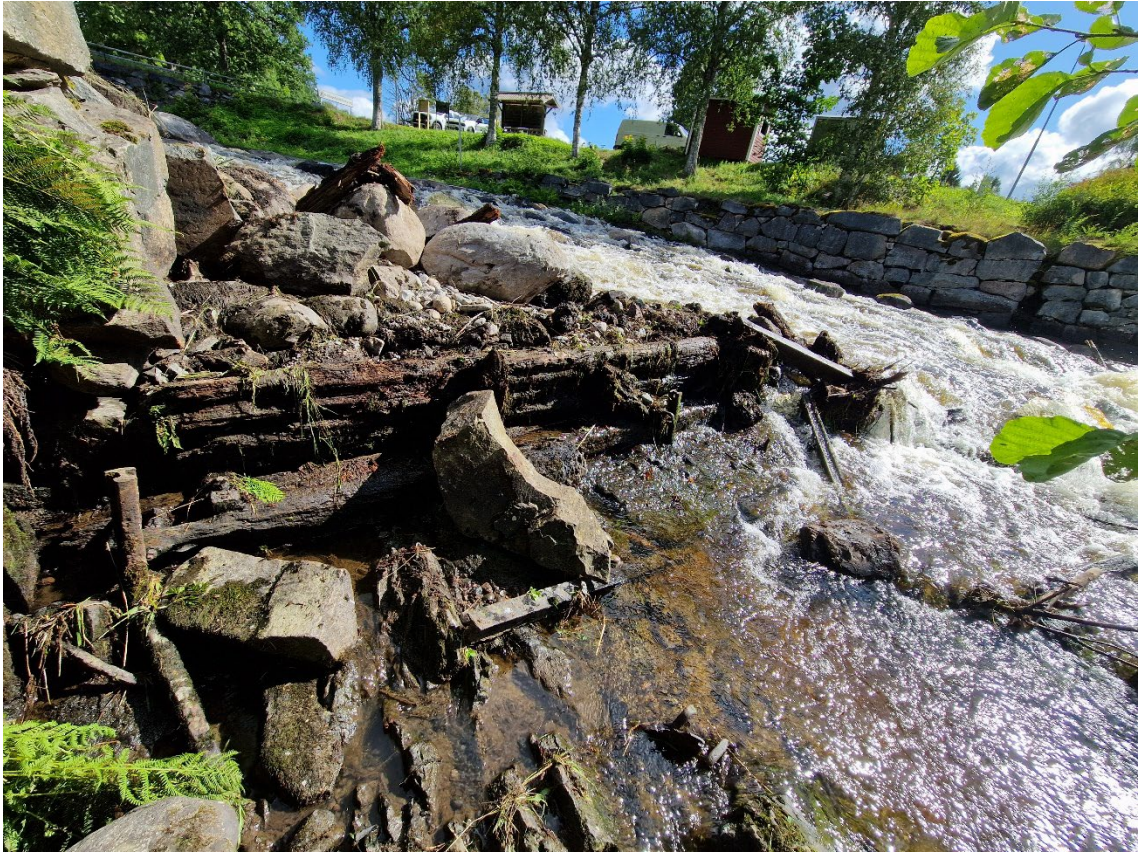
Figur 9. Rivning av den tidigare dammanläggningen (foto Norconsult).
