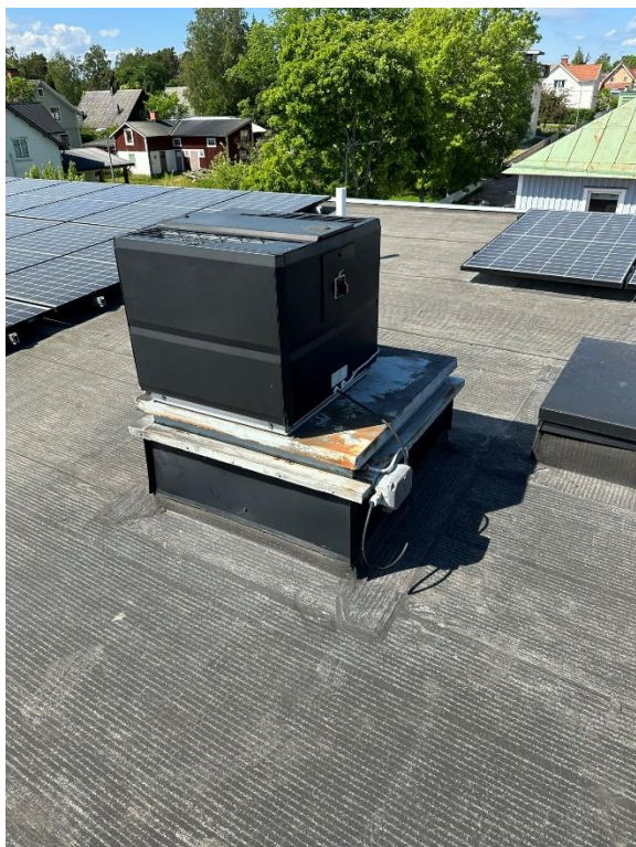
Takfläkt före projektet
