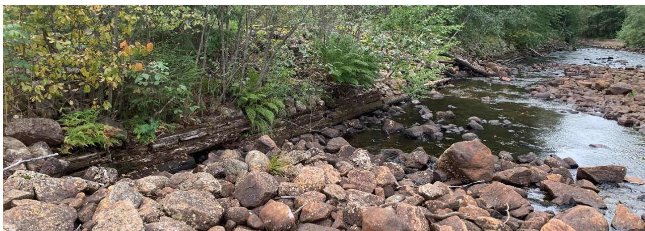
Figur 3. Dubbelkistor i vallen mellan de två befintliga öppningarna i högra vallen
