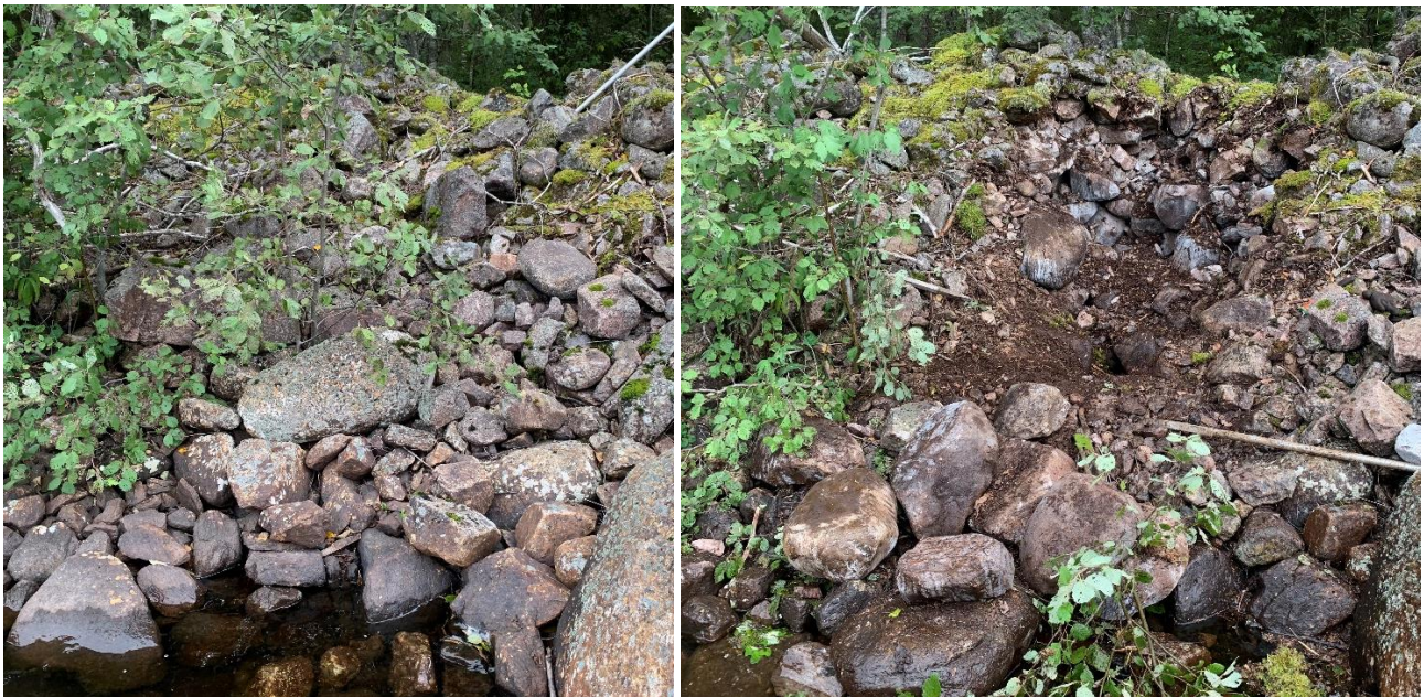
Figur 5. Före/efterbilder på första luckan som påbörjats på plats 1. Notera att blocken i högra bilden återfördes till älvfåran innan arbetet avslutades.
