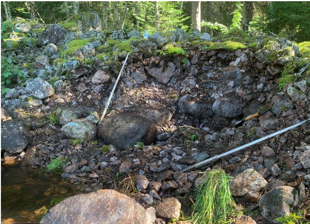
Figur 6, Den översta av två påbörjade öppningar på högersidan strax nedströms fämtfallet. Inget timmer, varken längsgående eller tvärgående kunde identifieras. Däremot vad som verkar vara en äldre rensvall av naturblock.
