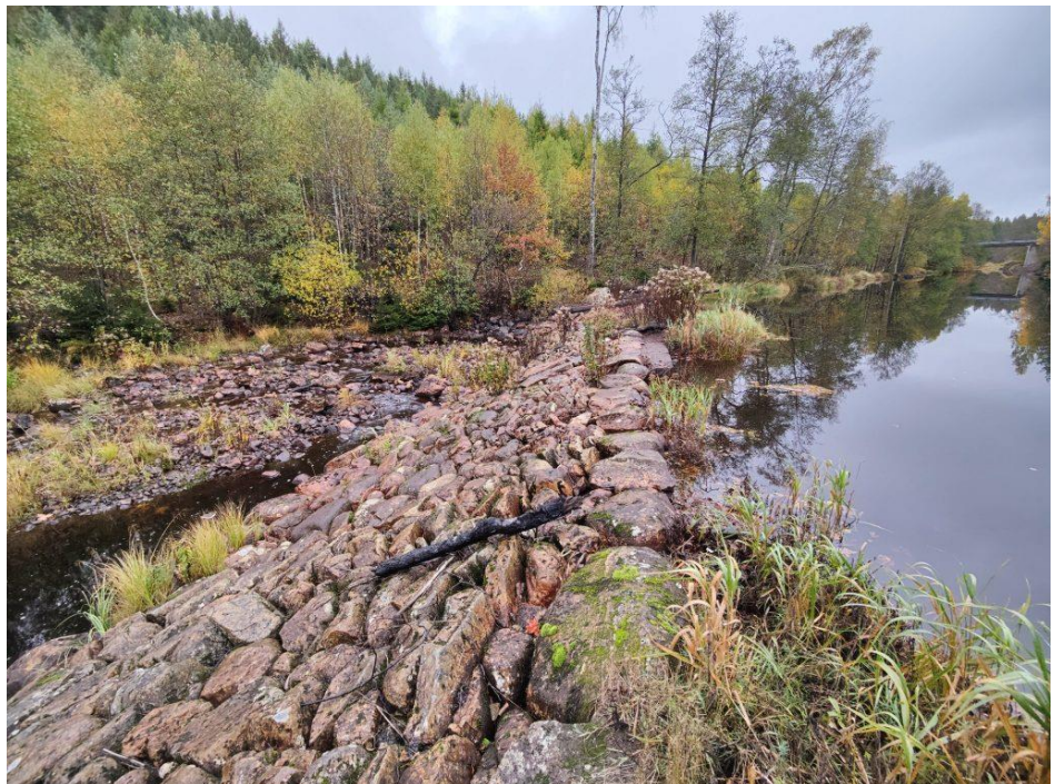
Figur 1. FÖREBILD. Överfallsdammen vid Fagerdala kraftverk utgjorde ett definitivt vandringshinder för alla förekommande fiskarter.
