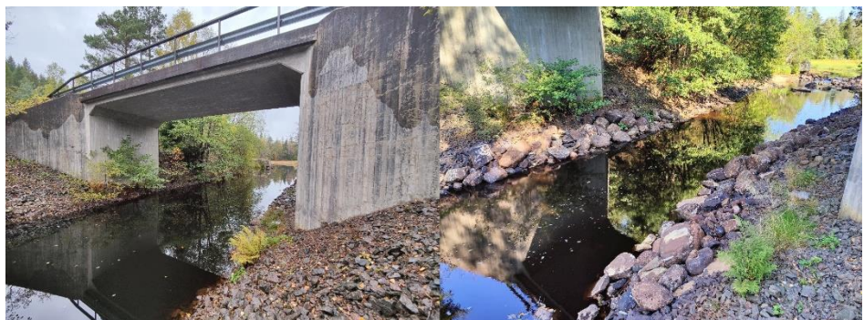
Figur 4. Före- och efterbild av erosionsskydd vid uppströmsliggande vägbro.
