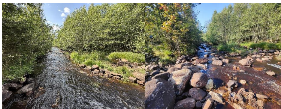
Figur 6. Före- och efterbild av naturfåran nedströms överfallsdammen.
