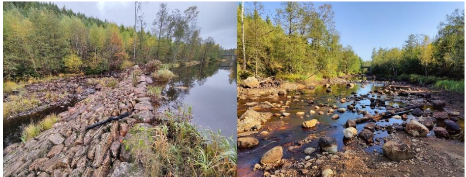
Figur 3. Före- och efterbild av överfallsdamm, vy uppströms.
