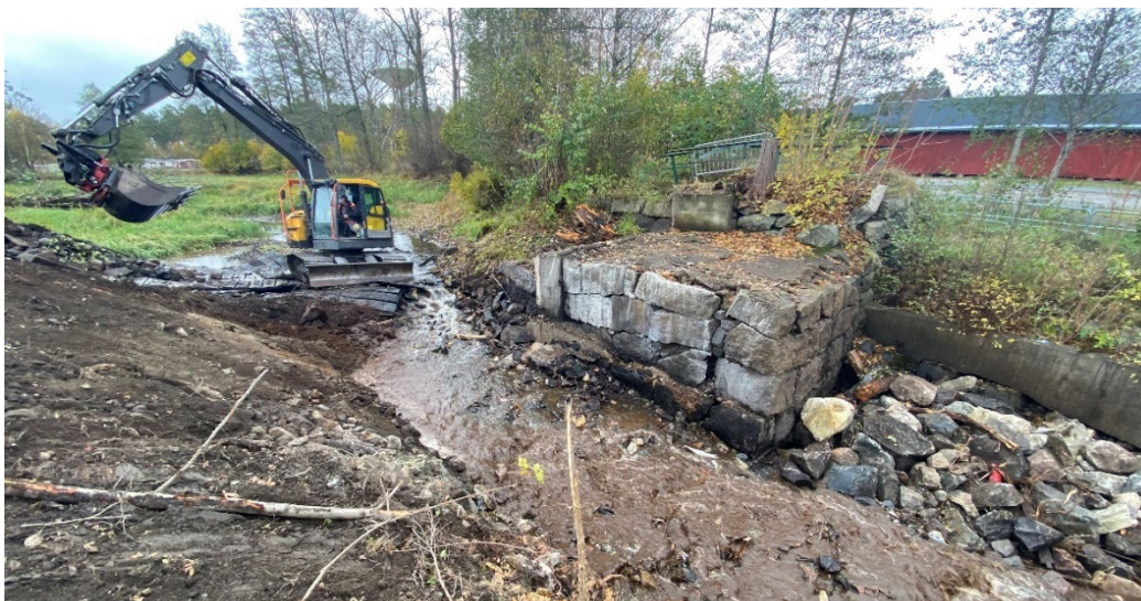
Pågående arbete vid Sulfitendammen under 2021.
