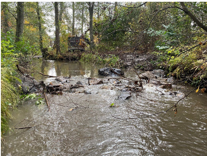
Trösklar har anlagts i ån för att höja basnivån så att kontakt med svämplan återetableras.
