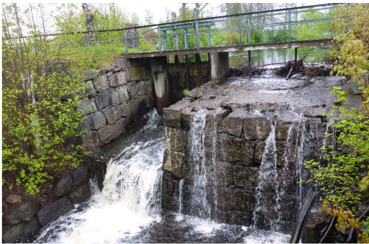
Den 4,4 meter höga Sulfitendammen innan åtgärd.
