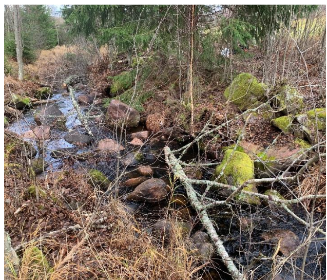
Figur 13. Ved som tillförts delsträcka 8. Samma fotovinkel som nedersta bilderna i Figur 12.
