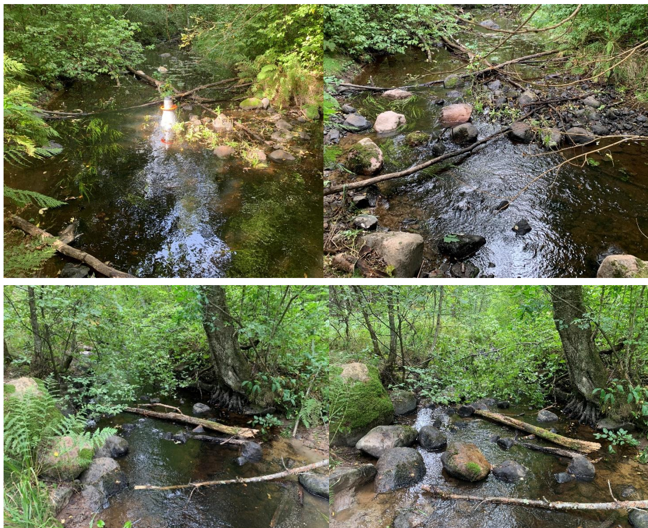
Figur 6. Före/efterbilder på delsträcka 3. Notera dock att på de övre två bilderna skiljer vattenståndet. Detta beror på att den låga vattenhastigheten gjorde att grumlingskyddet dämde upp nivån något under arbetets gång.
