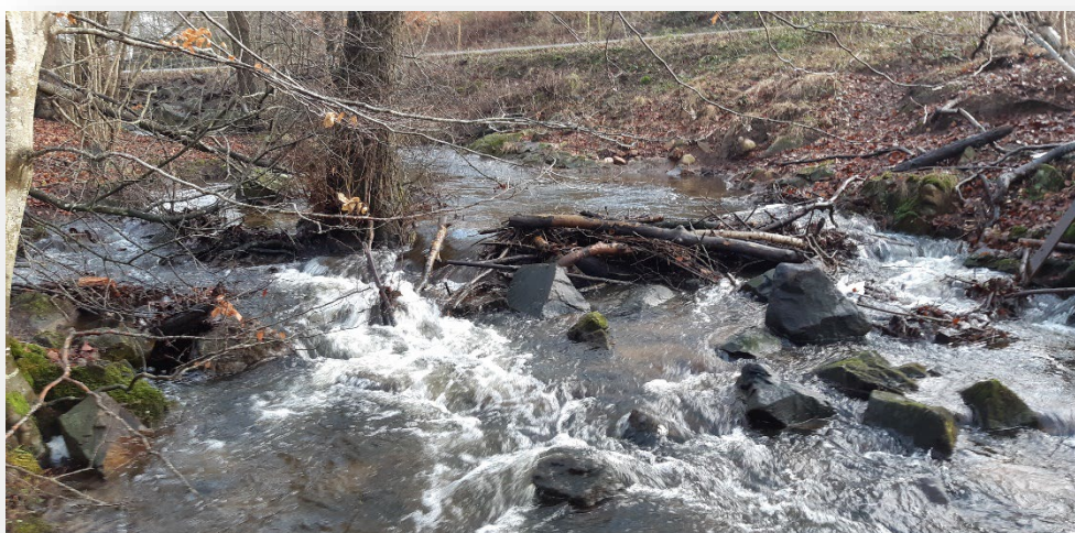
Bild 5. Efter åtgärd. Block och sten har fördelats ut längs vattendraget och den avstängda sidofåran till vänster i bild har öppnats upp (se figur 7).
