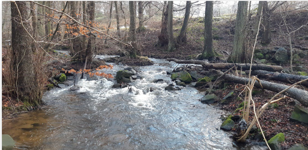
Bild 2. Efter åtgärd. Nu rinner vattnet ohindrat förbi stenfundamentet och möjliggör fiskvandring.
