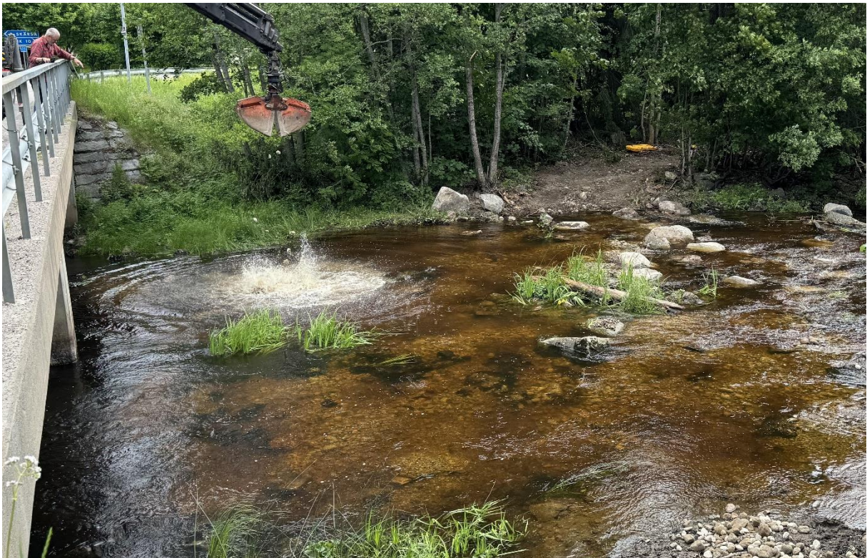
Lekgruset släpptes i ån från en bro med hjälp av en kranbil.
