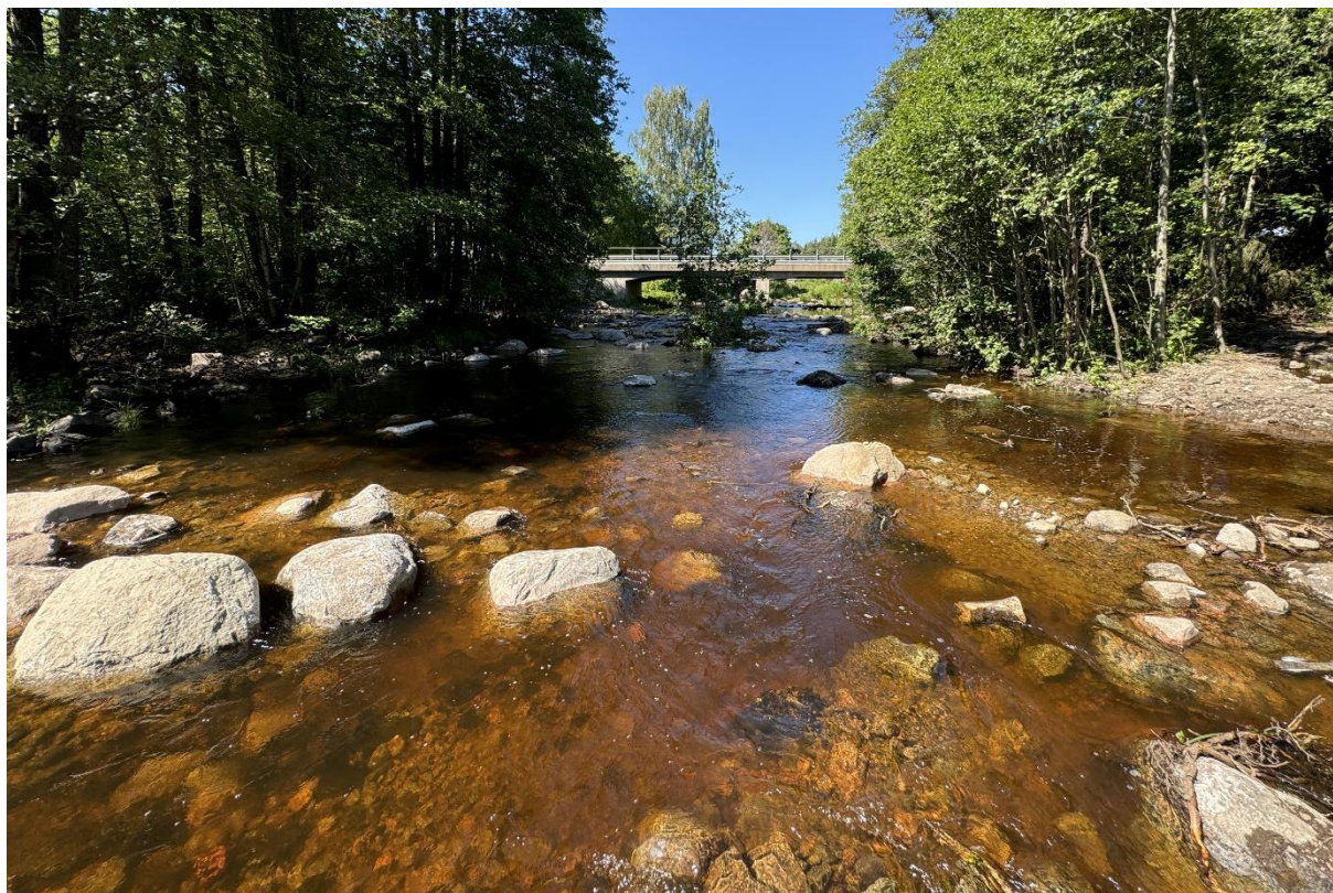
Samma del av huvudfåran efter åtgärd.
