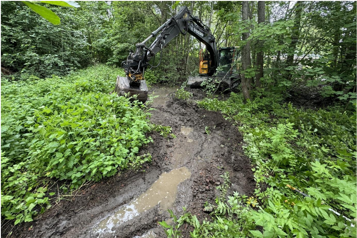
Aktivering av gamla isolerade sidofårar utgjorde en viktig del av arbetet i Lötån.
