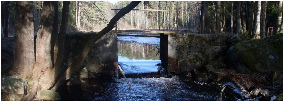
Den gamla dammtröskeln innan åtgärd (Foto Länsstyrelsen)
