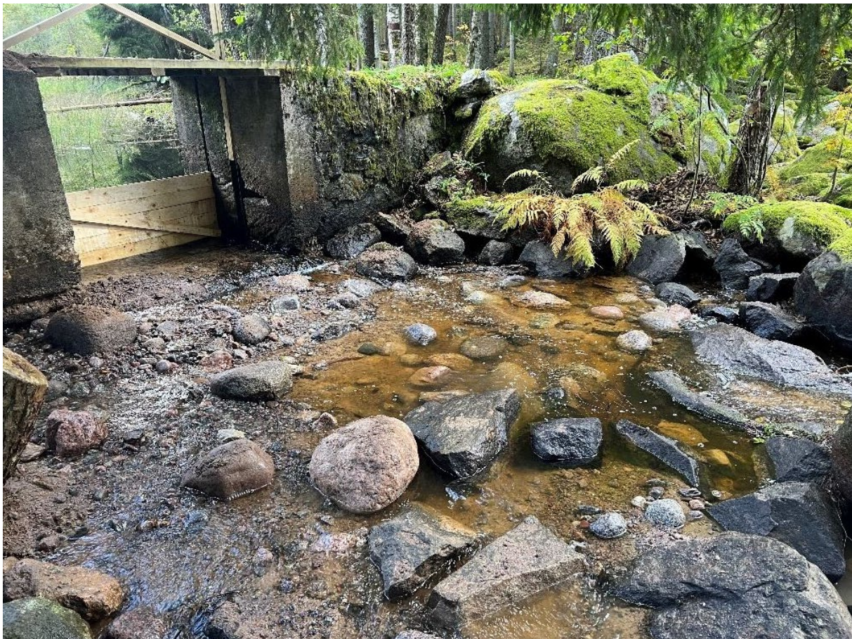
Upptröskling och bottenjustering nedströms dammtröskeln för att underlätta fiskvandring. Flödet har temporärt stängts under byggtid för att minimera grumling. (Foto vattenbyggnad)
