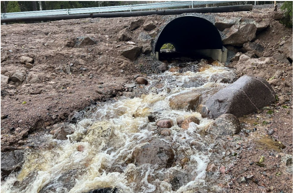
Uppströmsvy på nya trumman (Foto vattenbyggnad)
