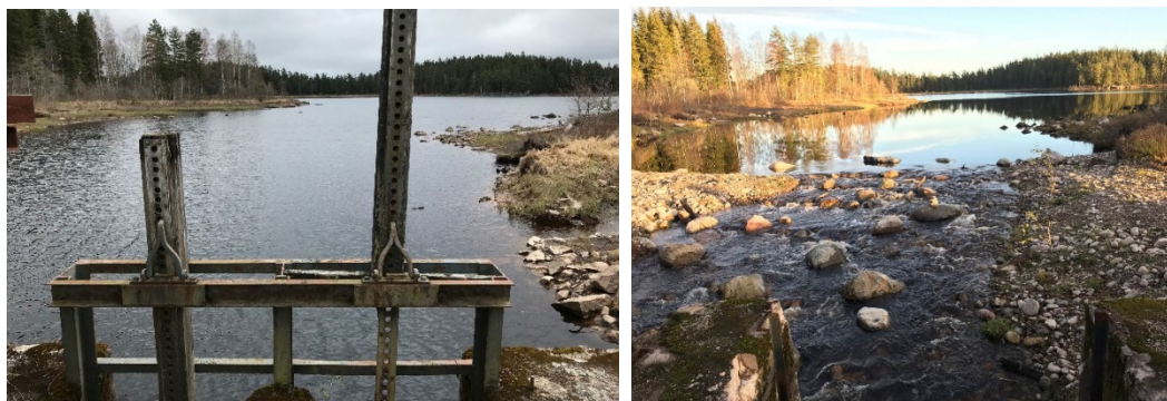
Figur 8. Angsjöns damm före åtgärd och sjöutloppet efter åtgärd Foto: Länsstyrelsen
