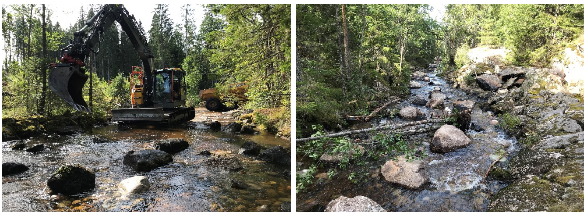
Figur 7. Arbete i Våtsjöälven och återställd flottningsrensad sträcka til höger, observera att kilstensmuren är sparad.
