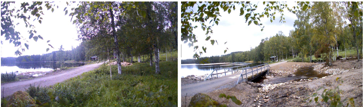
Figur 3. Dammsjödammen före och efter åtgärd
