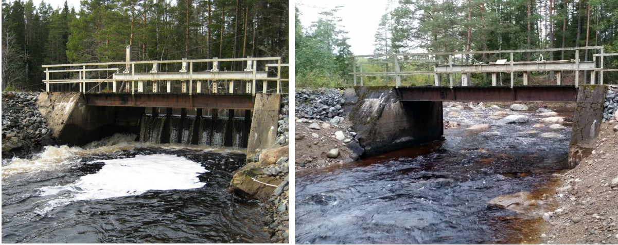
Figur 6. Gräntjärnsdammen före och efter åtgärd
